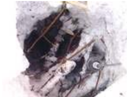
Einsatz der Kamera in einem durch Hochdruckwasser erzeugten Schacht
